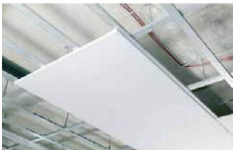
Montajul paralel cu profile de susținere structurală
