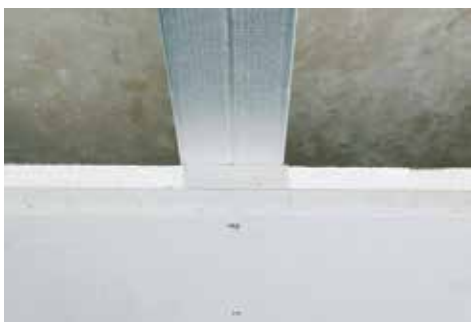
Montajul peste benzile de armare de pe spatele plăcii din gips-carton
